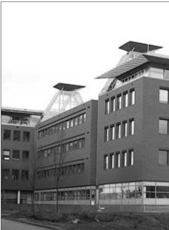
FOTO 1 ZONNESCHOORSTENEN GELEDEN HET GEBOUW TER PLAATSE VAN TRAPPENHUIZEN
