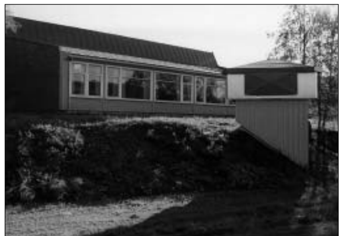
FIGUUR 2: LUCHTTOEVOERSCHOORSTEEN NAAR ONDERGRONDS TOEVOERKANAAL
