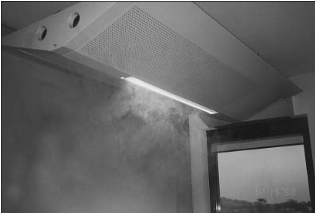
Foto 2 LUCHTTOEVOERPLENUMS
