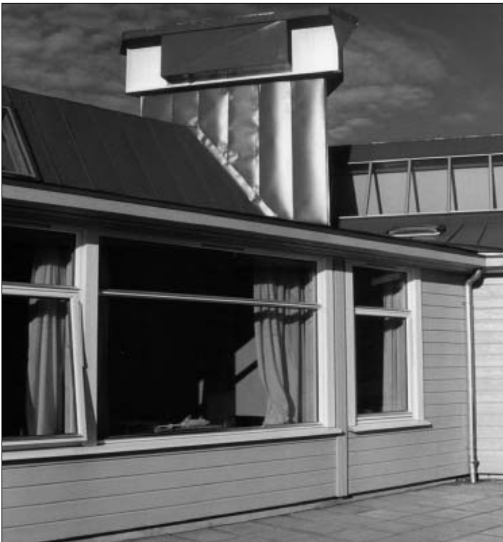
FIGUUR 4: BOUWKUNDIGE AFVOERSCHOORSTEEN
